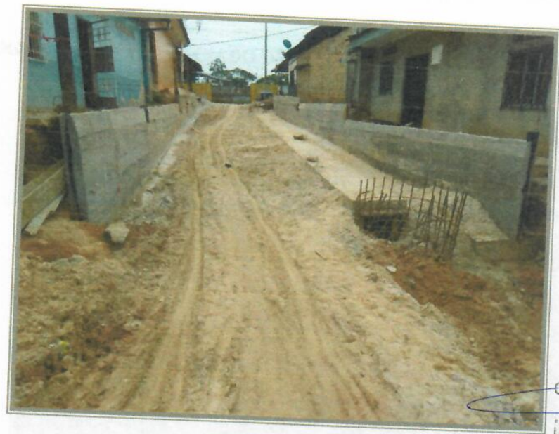
VISTA FOTOGRÁFICA N° 09 – CONFORMACION DE SUB RASANTE CA. AMERICA
