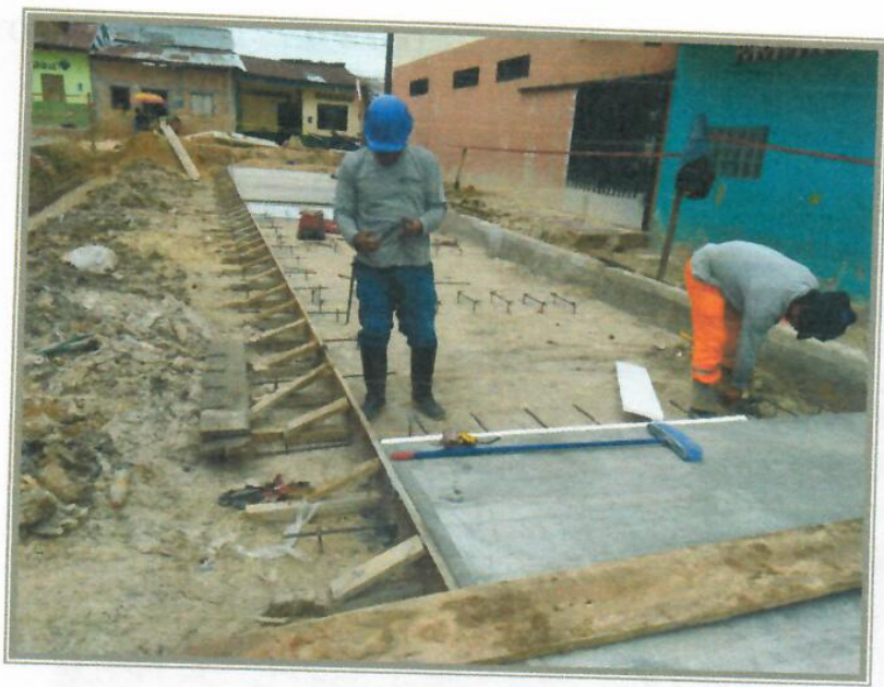
VISTA FOTOGRÁFICA N° 10 – VACEADO DE LOSA DE ROADURA EN CALLE LAGUNAS
