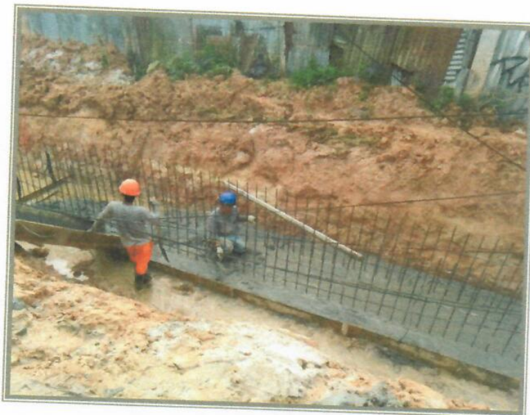
VISTA FOTOGRÁFICA N° 03 – VACEADO DE LOSA FONDO DE CANAL PSJ LAGUNAS
